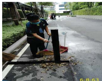
การทำความสะอาดท่อระบายน้ำ
