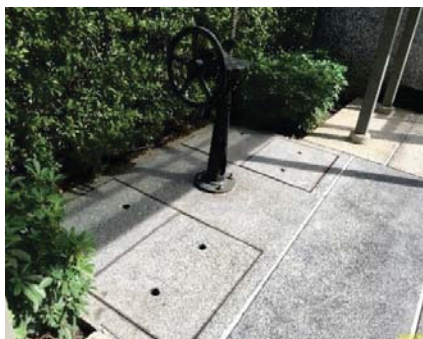
บ่อพักน้ำสุดท้ายก่อนระบายออกสู่ท่อ สาธารณะ และประตูน้ำ
