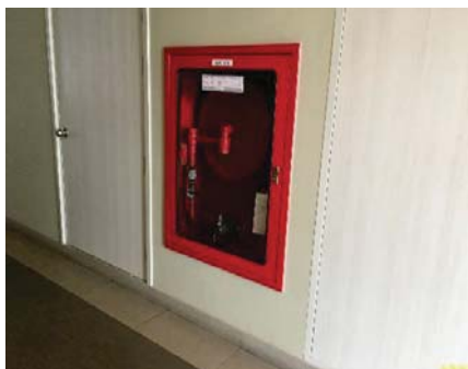
ตู้เก็บสายฉีdn้ำดับเพลิง
