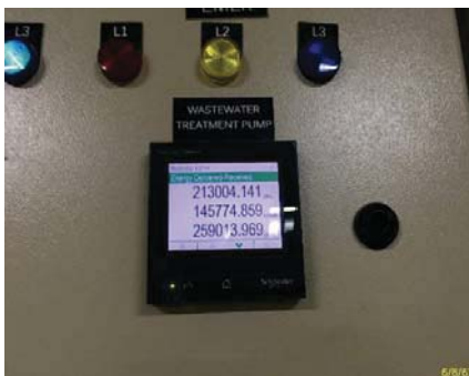
มิเตอร์ไฟฟ้าระบบบำบัดน้ำเสีย
